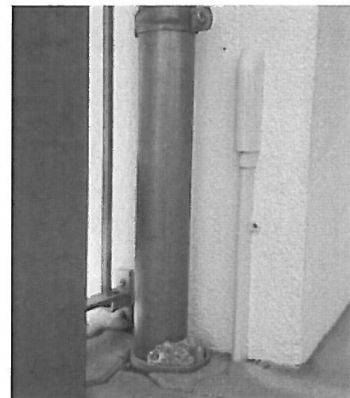
überirdische Hauseinführung
